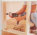
6 Каркас фиксируется к стене и крепится затем к карнизной стене дюбелями и болтами.
