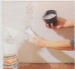
9 Для завершения работы шлифшкуркой все швы и проклейте шпаклю со стеной (см. наш совет).
